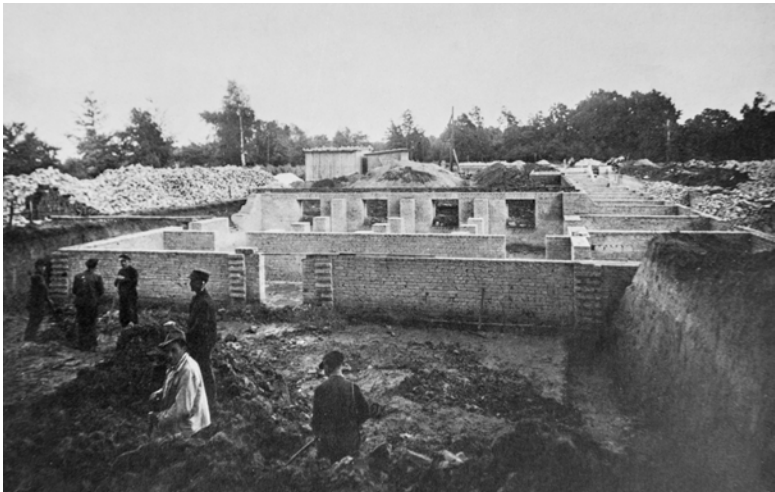
DER BAUBEGINN WAR EINE GEMEINSCHAFTSLEISTUNG Foto: Archiv der Akademie
